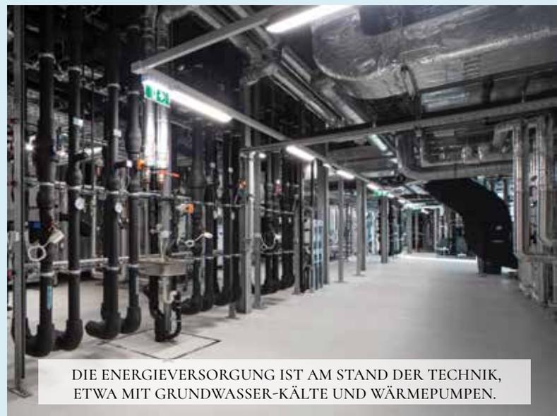
DIE ENERGIEVERSORGUNG IST AM STAND DER TECHNIK, ETWA MIT GRUNDWASSER-KÄLTE UND WÄRMEPUMPEN.
